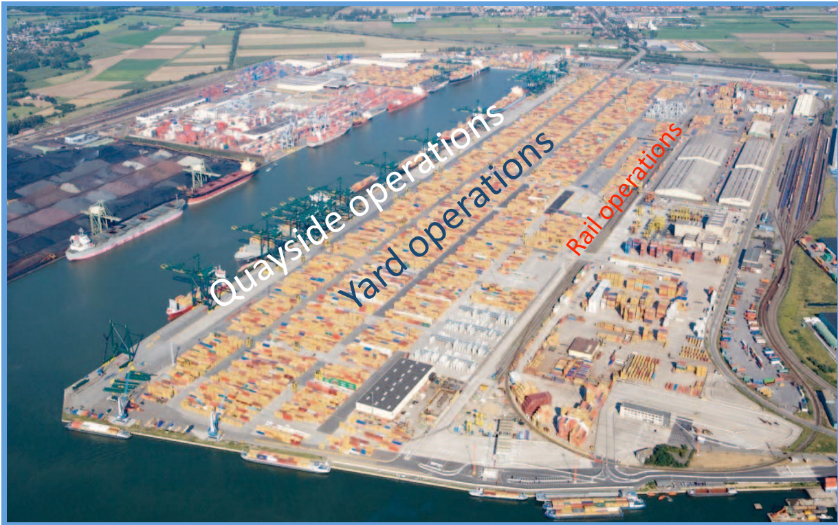
Separazione modale nel container terminal di MSC (Home Terminal) ad Anversa
