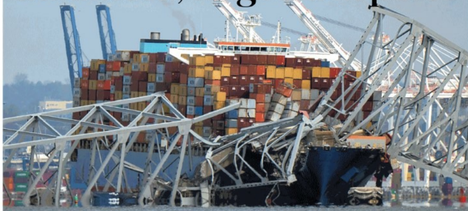
Le macerie del Francis Scott Key Bridge di Baltimora dopo l'impatto della portacontainer Dali contro un pilone
