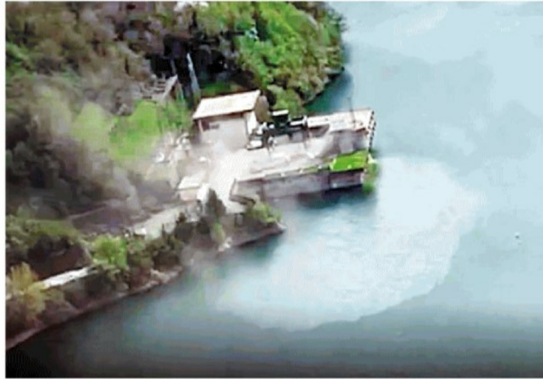
Nelle immagini riprese dall'elicottero dei vigili del fuoco la centrale idroelettrica Enel di Bargi, sul lago artificiale di Suviana, nell'Appennino bolognese
