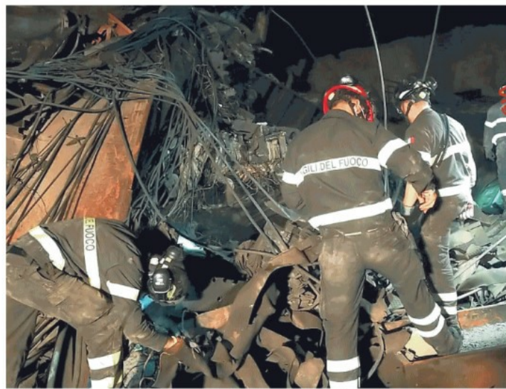
I vigili del fuoco scavano tra i rottami della centrale Enel di Bargi, sotto il lago di Suviana
