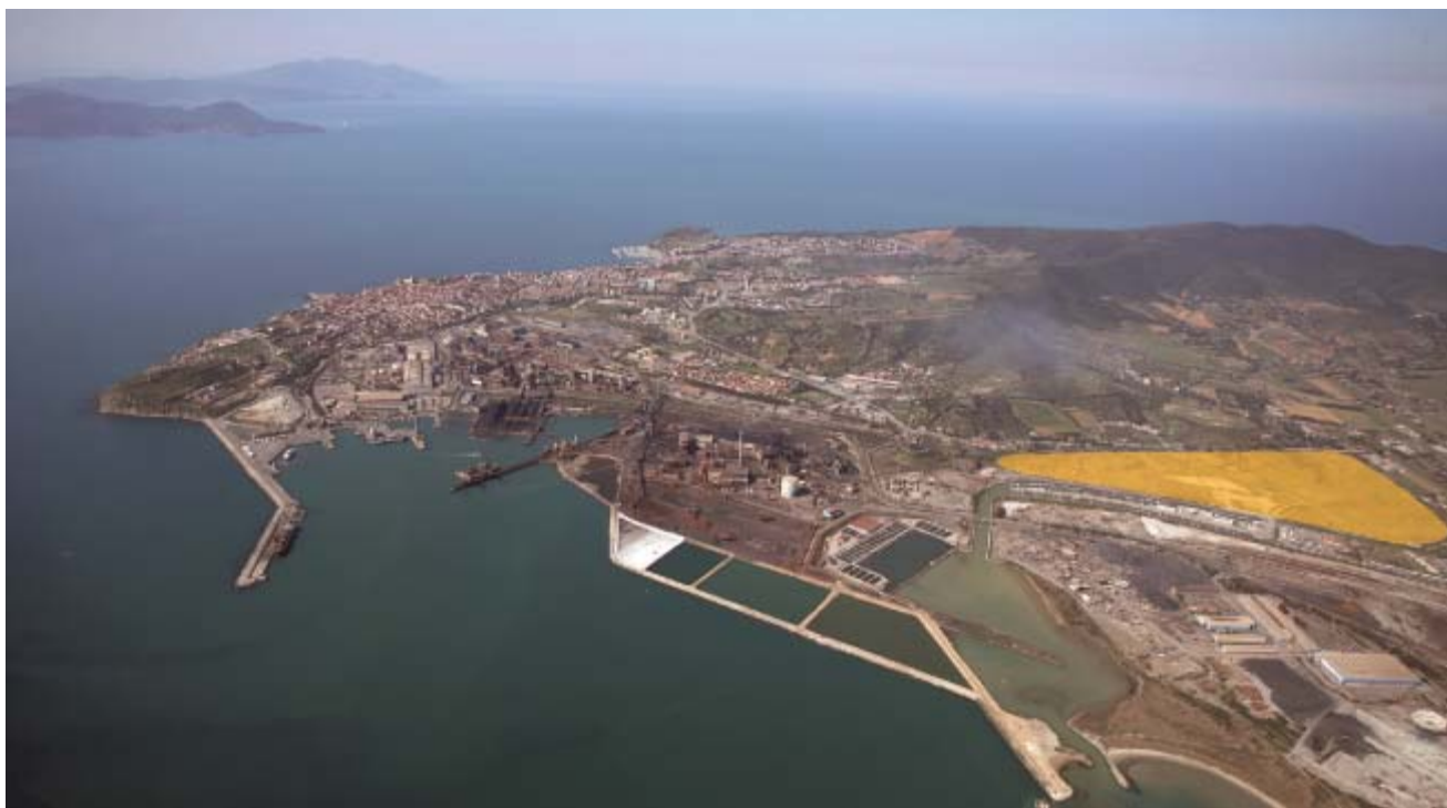
Fig. 10: Panoramica del porto con in evidenza le aree retroportuali
