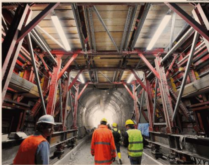
Il tunnel sotto le Alpi. Il cantiere della Tav a Chiomonte: secondo l'analisi tecnica pubblicata ieri dal M5S i costi superano di 7-8 miliardi i benefici
