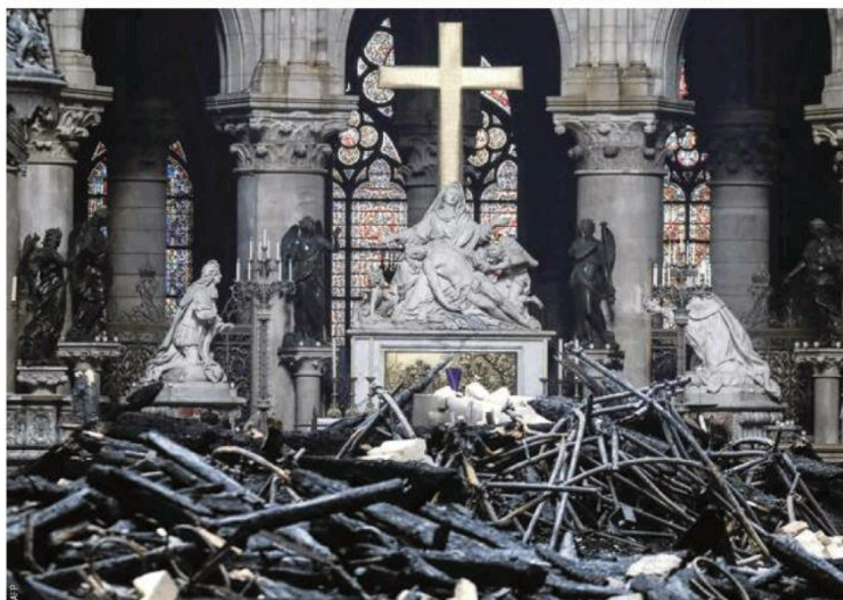
La "foresta" in travi di legno, che era a sostegno della copertura di Notre-Dame, completamente divorata dalle fiamme e crollata nella campata centrale della cattedrale
