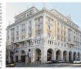
L'edificio sede della Assicurazioni Generali a Trieste.
