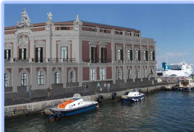
Cantiere di restauro Immacolatella vecchia
