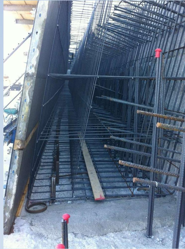
Esempi di un nuovo muro in calcestruzzo armato con barre di acciaio di 40 mm
