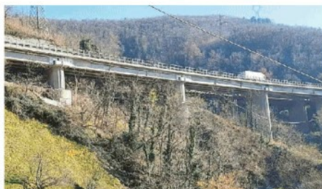
Il viadotto autostradale Pecetti, sopra Mele, è uno dei sorvegliati speciali
