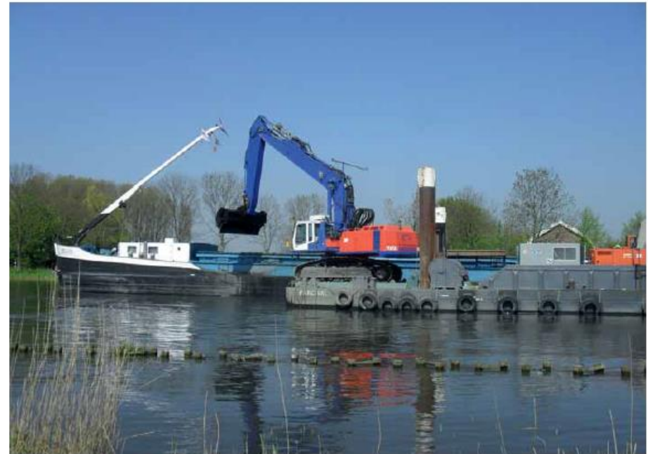
FIGUUR 3: HET UITEINDELIJK BAGGEREN VAN DE WATERBODEM.
