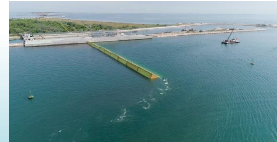
Test barriera di Chioggia parte agosto
