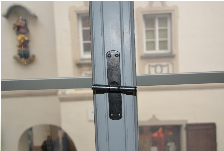
Visione dall'esterno, lavorazione del telaio e tipo di ferramenta
