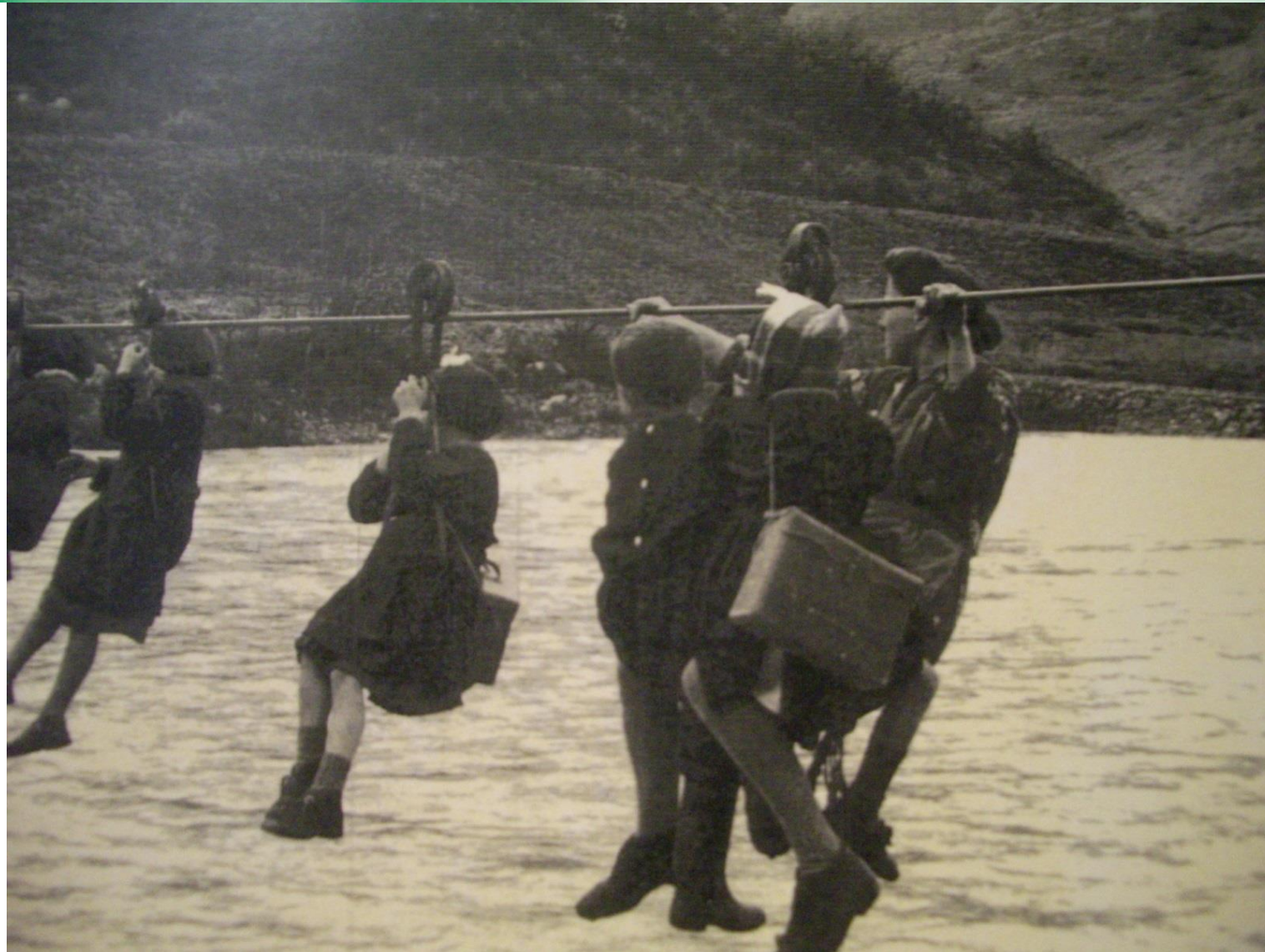
Novembre 1966 alluvione nel bolognese – Teleferica per la scuola
