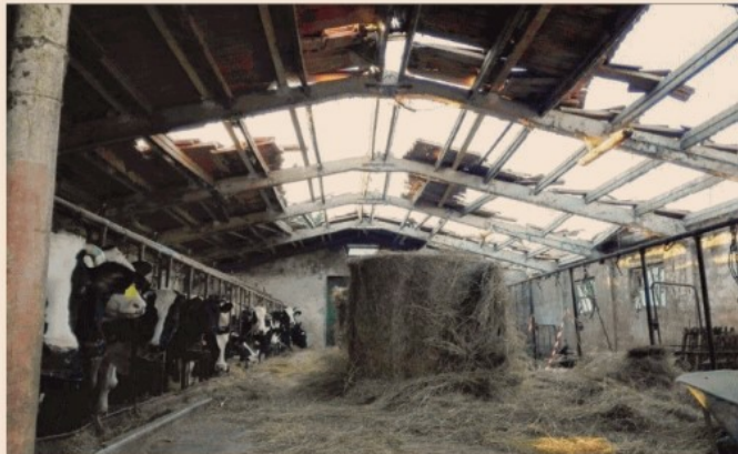
In difficoltà ancora 25 mila aziende. Un ricovero per animali in Umbria con il tetto in buona parte lesionato dal sisma
