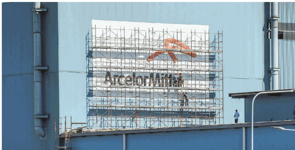
A distanza di quasi quattro mesi dall'installazione della nuova insegna sullo stabilimento di Genova, il gruppo ArcelorMittal ha deciso di lasciare l'Italia
