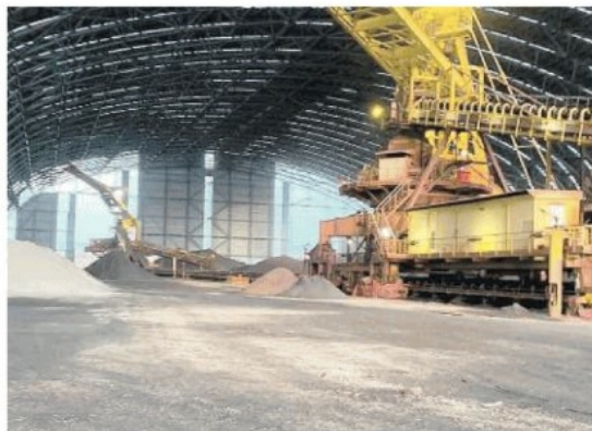
I capannoni dell'ex Ilva come si sono presentati ieri al sopralluogo dei commissari
