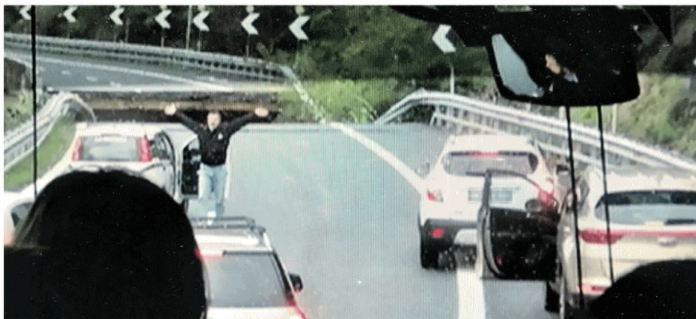
▲ L'allarme Daniele Cassol, 56 anni, si sbraccia per fermare le altre vetture sul viadotto crollato lungo la A6 Torino-Savona
