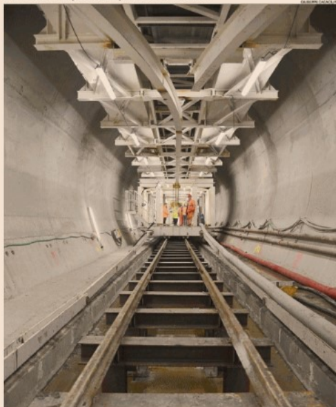
Opera strategica. Il tunnel ferroviario della futura linea ad alta velocità Torino-Lione
