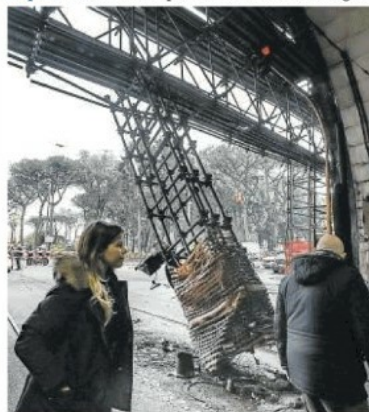
Il pilone crollato all'ingresso della galleria Vittoria Novati (A. Di Lorenzo)
