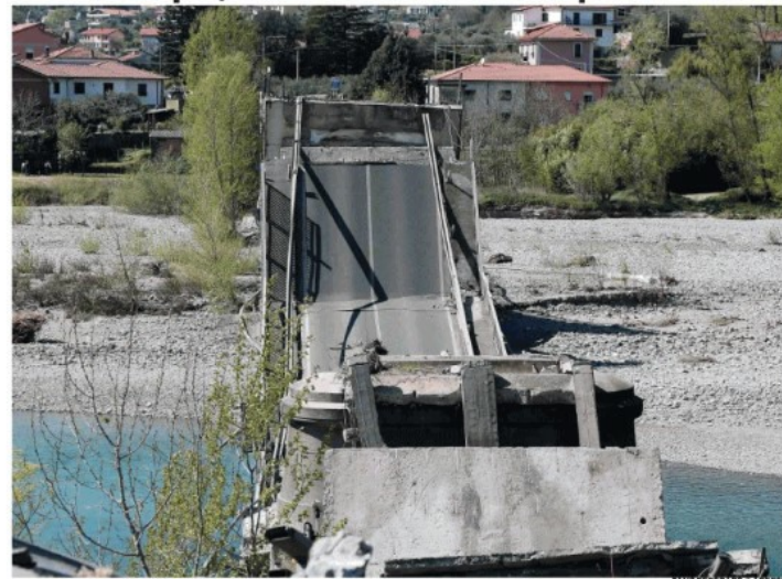
Il viadotto crollato sul fiume Magra tra Massa Carrara e La Spezia, in Lunigiana PINNA E VIVOLI - PP. 14-15
