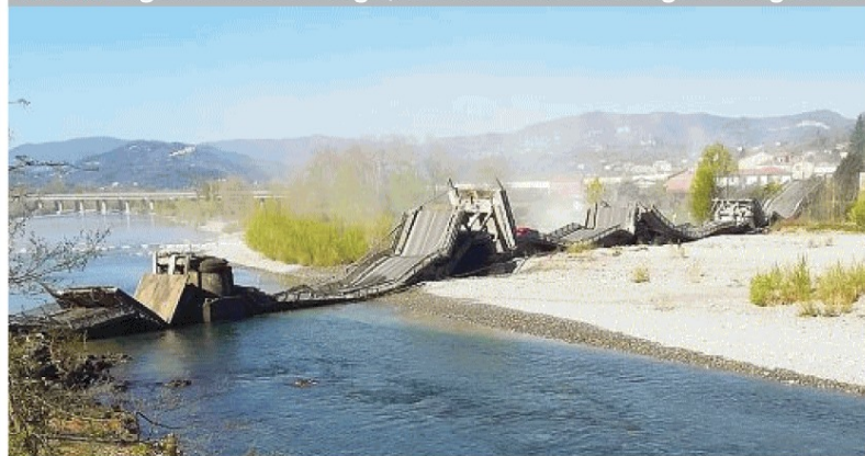
Il ponte sulla SP07 accartocciato su se stesso e appoggiato sul greto e sul letto del fiume Magra, ad Aulla (Massa Carrara), tra la Liguria e la Toscana
