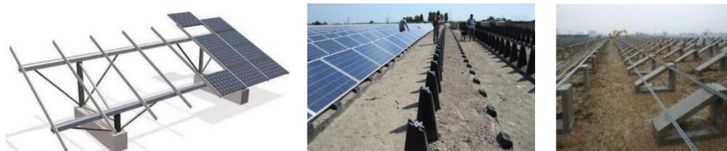
Figura 5.9: La disposizione dei pannelli a terra
