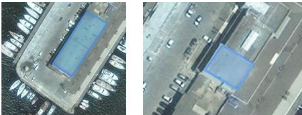
Figura 5.19: Edifici di pertinenza della AdSP di Cagliari (Fonte: Ns. elaborazione.)
