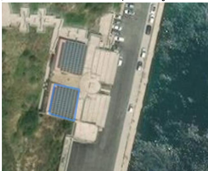
Figura 5.25. Area localizzata presso il Terminal passeggeri di Santa Teresa di Gallura (Fonte: Ns. elaborazione.)
