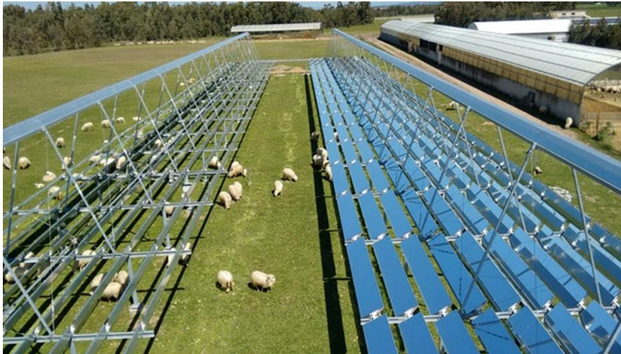
Figura 5.30. Impianto solare termico con collettori Fresnel del caseificio Nuova Sarda Industria Casearia (Fonte: qualenergia.it )
