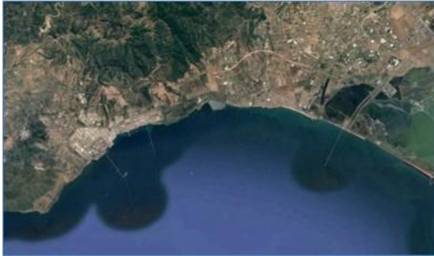
Figura 3.4 Polo petrolchimico del porto di Cagliari
