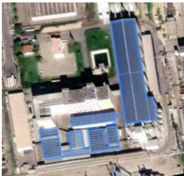
Figura 5.17. Impianto fotovoltaico installato da Simec SpA nelle aree di Santa Giusta (Porto di Oristano): test delle stime di calcolo (Fonte: Ns. elaborazione)
