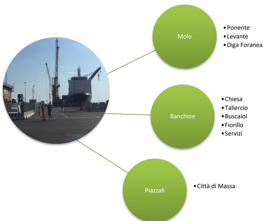
Figura 18 - Infrastrutture marittime del porto di Marina di Carrara
