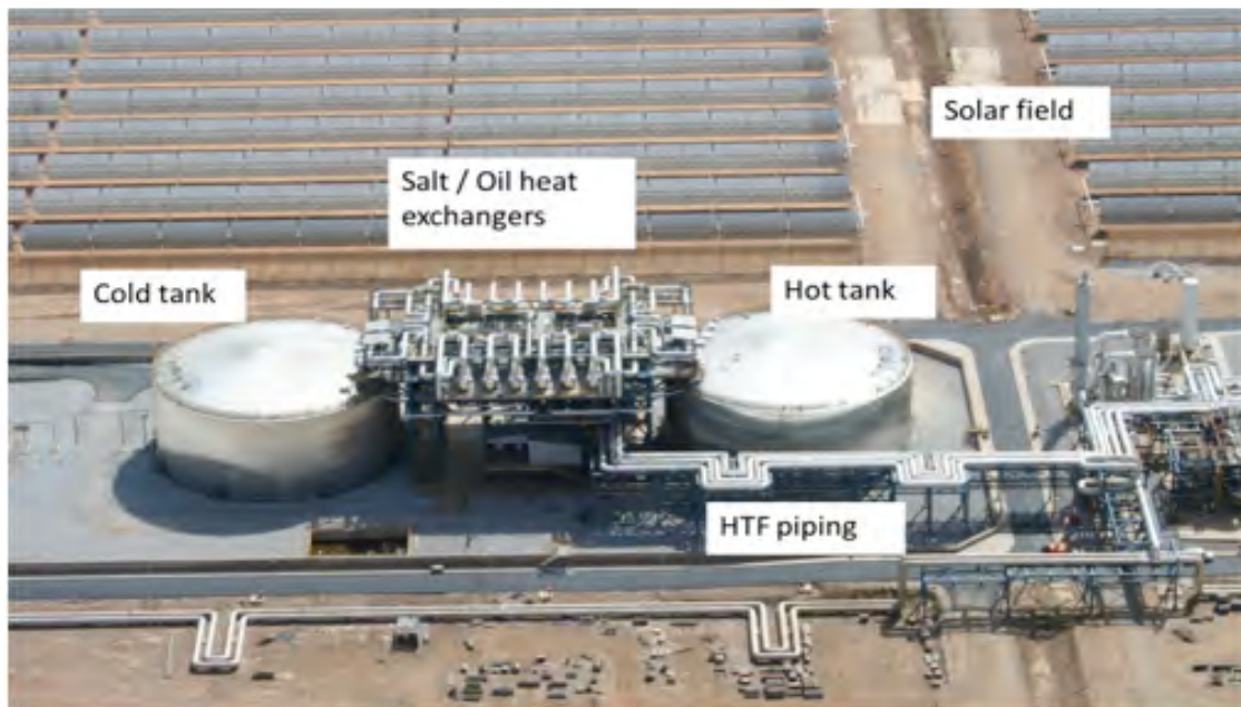
Sistema di accumulo termico da 1 GWh a due serbatoi e sali fusi dell'impianto solare Andasol (Spagna) da 150 MW.
