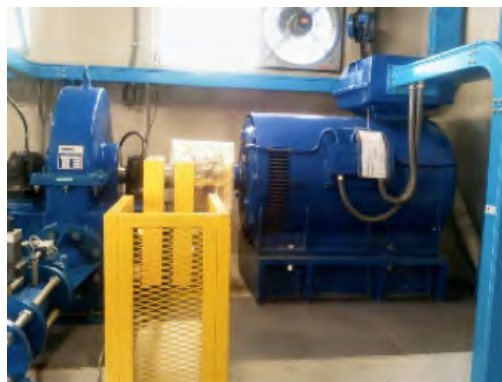
Centralina idroelettrica nell'acquedotto di Roncobello (BG) [18]
