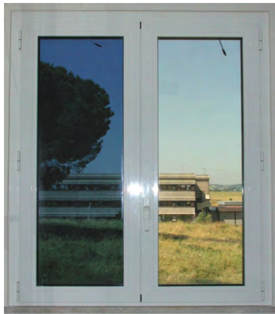
Finestra con vetri elettrocromici (Fonte: ENEA)
