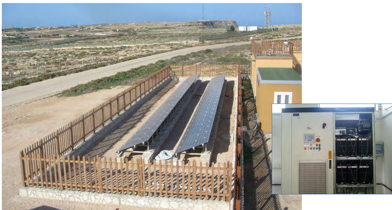
Impianto fotovoltaico con sistema di accumulo (nel riquadro) presso il CR ENEA di Lampedusa
