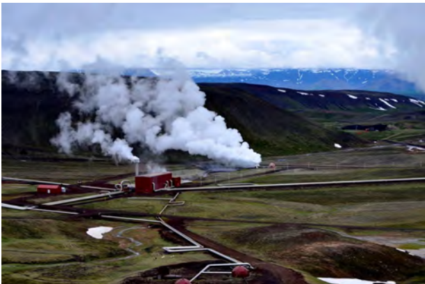
Impianto geotermico in Islanda
