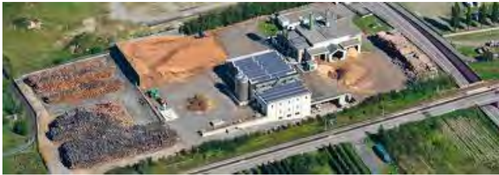
La centrale di Tirano (Fonte http://tcvvv.it/le-centrali/tirano )
