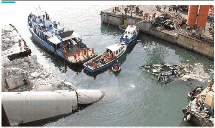
«lo, assolto per la torre piloti, sogno il crollo ogni notte» Le macerie della torre piloti di Genova, crollata nel 2013 per la manovra della Jolly Nero. I morti furono 9 INDICE / PAGINA 13
