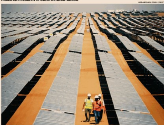
Transizione verde. Il più grande impianto fotovoltaico d'Africa a Benban, Egitto, progetto al quale ha contribuito la Bers
