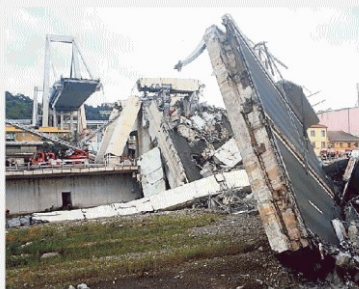
Le macerie del ponte Morandi poco dopo il crollo
