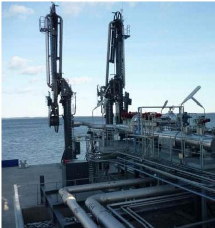
**Figura 9 - Bracci di carico da 8 e 6 '' per il carico di una GNL ship fino a a15,000 mc al terminale in Svezia**
