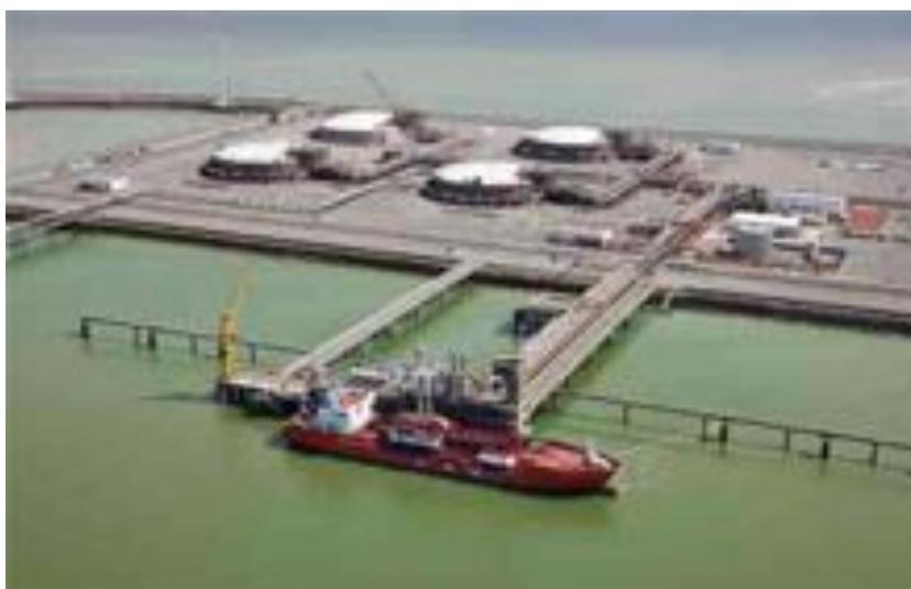
**Figura 20 - La metaniera Coral Methane durante le operazioni di rifornimento presso il terminale GNL di Zeerbrugge (primo caricamento di GNL bunker vessel da terminale GNL)**
