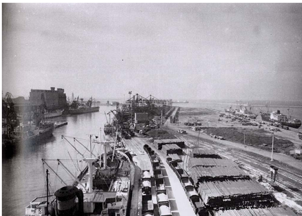
Fig. 13 – La Calata Alto fondale in costruzione, 1955
