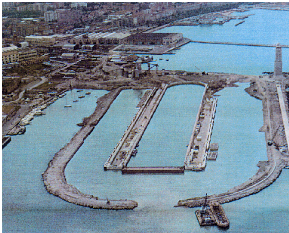
Figura 19-II Grande Bacino in costruzione - 1974
