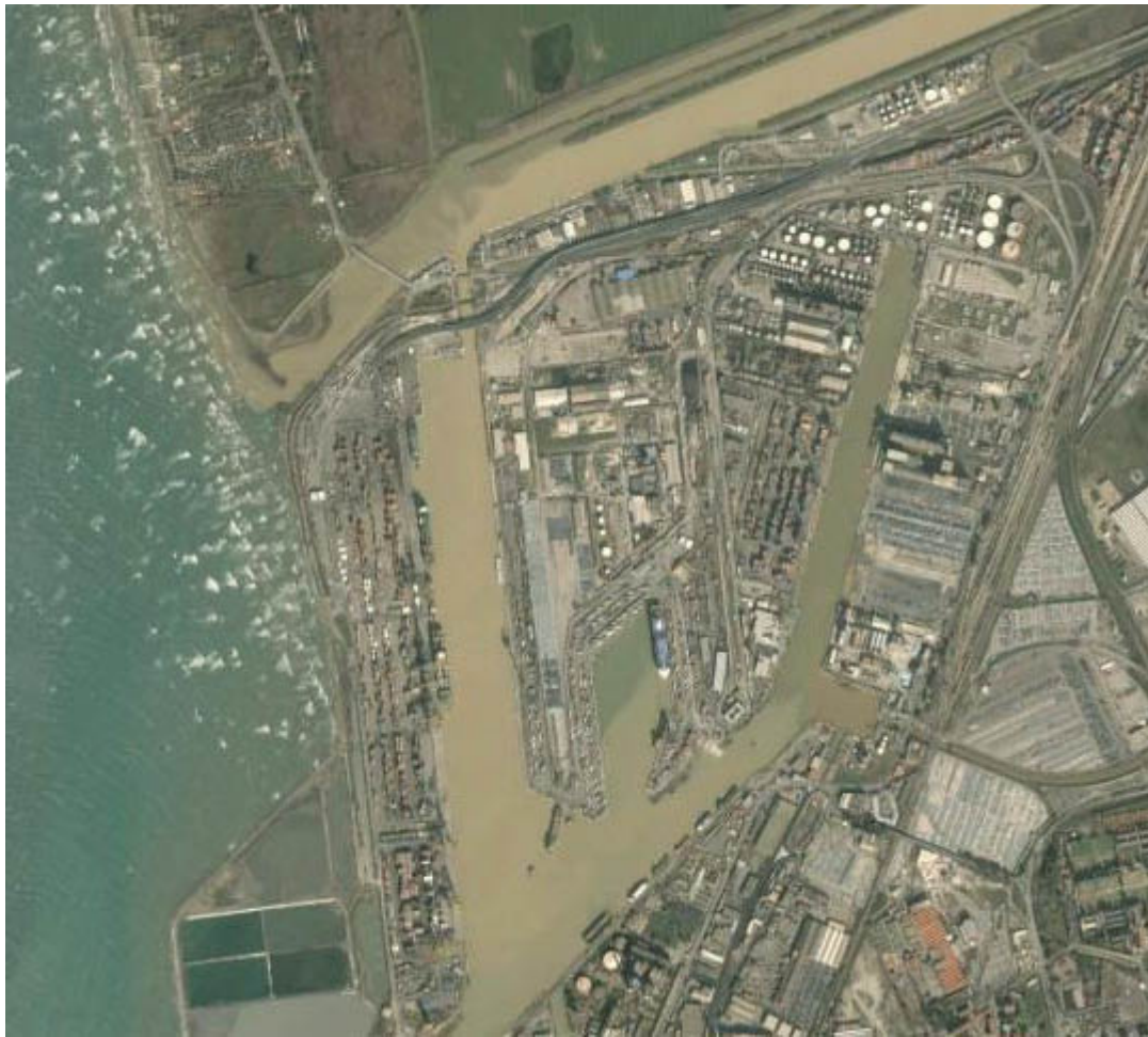
Figura 19 - Scolmatore in piena
