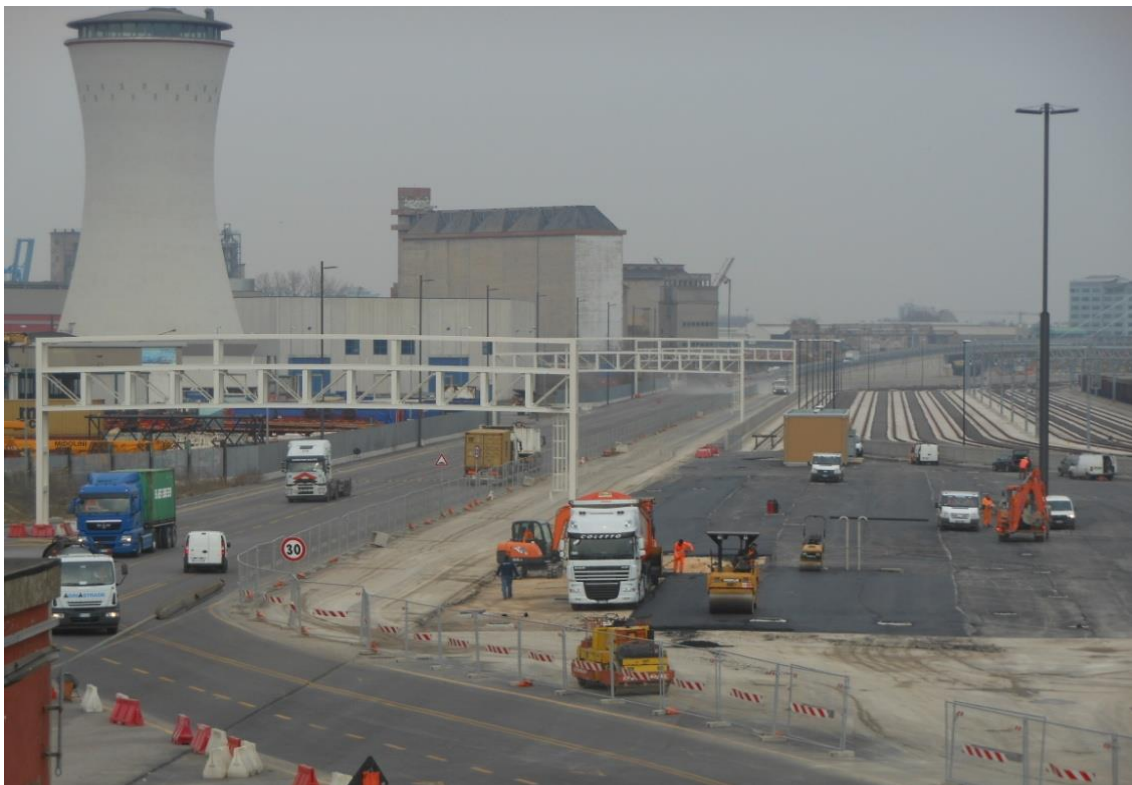
Lavori in via dell'Azoto
