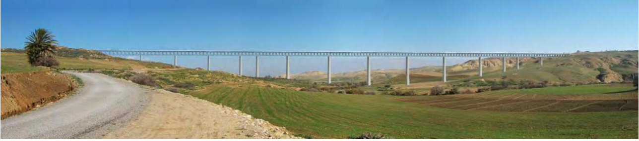
Figura 5 - Linea AV OuedTlelat – Tlemcen (Algeria): viadotto VI33 (L=1780 m; Ouedlsser)
