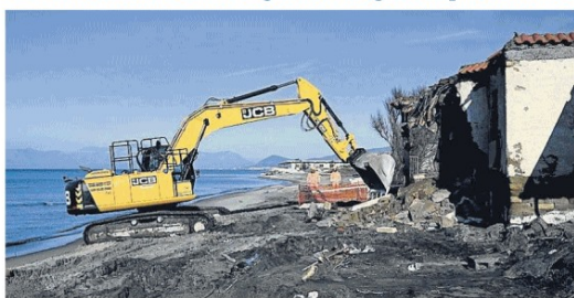
Le ruspe in azione a Castel Volturno, in località Bagnara, per abbattere una casa abusiva
