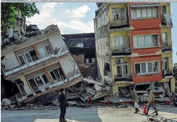
Gli edifici «trappola» della città storica di Antakya, in Turchia, crollati durante il terremoto di magnitudo 7,8
