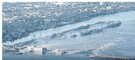
La diga di Nova Khakovka bombardata: allagati i villaggi lungo il Dnipro, migliaia di evacuati
