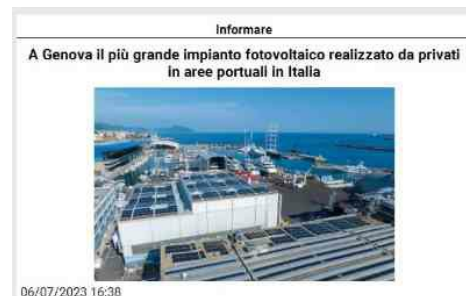
Informare A Genova il più grande impianto fotovoltaico realizzato da privati in aree portuali in Italia 06/07/2023 16:38 È stato installato dal cantiere Amico & Co. con un investimento di circa un milione di euro 7 giugno 2023 Il cantiere genovese Amico & Co., specializzato nel settore delle riparazioni e ristrutturazioni di super e mega yacht, ha posto in funzione un nuovo impianto fotovoltaico che garantisce energia rinnovabile per coprire 53% del fabbisogno annuo dell'attività dello stabilimento e del nuovo Waterfront Marina. Si tratta del più grande impianto realizzato da privati in aree portuali in Italia: sviluppa complessivamente una potenza massima di circa un MegaWatt di picco (MWp), conta 1.782 pannelli solari e occupa una superficie di circa 4.300 metri quadrati sfruttando le coperture dei capannoni e delle strutture del cantiere e del Marina. L'impianto è stato realizzato per conto di Amico & Co. dalla società Ceresa Next Srl. L'azienda ha specificato che l'installazione del nuovo impianto, che ha comportato un investimento di circa un milione di euro, è l'ultimo dei numerosi interventi realizzati che hanno avuto come obiettivo l'azzeramento delle emissioni delle imbarcazioni che sostano da Amico & Co. ai lavori o in Marina e la riduzione dell'impatto delle lavorazioni di riparazione, a partire dalla elettrificazione delle banchine del cantiere nel 2007/2009, alla realizzazione di capannoni e strutture fisse (bacini) in grado di confinare e isolare in maniera efficiente le imbarcazioni durante le lavorazioni (2010/2014), dalla realizzazione dello ShipLift, sistema di alaggio, varo e movimentazione di unità fino a 95 metri di lunghezza totalmente elettrificato con zero emissioni in situ (2019), al nuovo Waterfront Marina (2020/21) dove gli yacht in sosta sono allacciati alla rete elettrica e a quella fognaria. La prossima sfida di Amico & Co è già iniziata e riguarda l'applicazione di tecnologie innovative per la realizzazione di progetti di retrofit e di trasformazione dei super e mega yacht esistenti con l'obiettivo di contribuire alla transizione ecologica della flotta mondiale. Intanto Amico & Co. ha pubblicato il proprio primo
