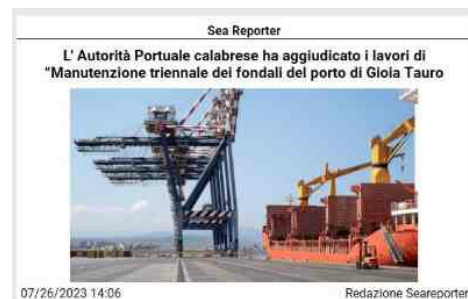
07/26/2023 14:06 Redazione Seareporter Gioia Tauro, 26 luglio 2023 - L'Autorità di Sistema portuale dei Mari Tirreno meridionale e Ionio ha aggiudicato i lavori di "Manutenzione triennale dei fondali del porto di Gioia Tauro tramite lo spianamento delle dune sottomarine". Si tratta di un intervento necessario a mantenere costante la profondità del canale portuale che, a causa delle dune generate dal movimento delle navi in entrata e uscita in porto, devono essere livellate al fine di garantire la sicurezza della navigazione. Con fondali profondi 18 metri, in Italia, solo a Gioia Tauro possono entrare le navi di ultima generazione, capaci di trasportare oltre 24 mila teus. L'obiettivo dell'Ente, guidato dal presidente Andrea Agostinelli, è quindi quello di assicurare la capacità dello scalo portuale, primo porto di transhipment a livello nazionale e tra i primi in Europa e nel bacino del Mediterraneo, di accogliere i giganti del mare di lunghezza superiore a 400 metri e larghezza di oltre 60 metri, che solcano quotidianamente il porto di Gioia Tauro. Il programma degli interventi di livellamento di durata triennale (2023/2026), con cadenza trimestrale, avrà inizio nei primi giorni di settembre e prevede complessivamente dodici interventi. Ogni anno sono previsti quattro interventi, resi necessari a mantenere sempre efficienti le quote dei piani di pescaggio. I lavori riguarderanno lo spianamento del fondale marino senza asportazione di sabbia. Per ogni singolo intervento di manutenzione trimestrale è previsto un tempo massimo di cinque giorni, utilizzando una draga THSD, o di dieci giorni utilizzando un altro mezzo marittimo idoneo al livellamento dei fondali. L'intervento si riterrà ultimato al raggiungimento di 30 mila metri cubi di sabbia livellata. Riunitosi nella mattinata di ieri in forma pubblica, il Comitato di Gara, dopo avere verificato la correttezza della documentazione prodotta dai concorrenti, ha affidato l'esecuzione dei lavori al Raggruppamento di imprese temporaneo composto dalla ditta Dravo Sa, con sede legale in Spagna, e dalla ditta La Dragaggi
