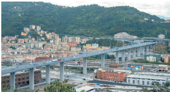
Il crollo del Morandi e il nuovo ponte, due immagini simbolo (FOTO PAMBIANCHI)
