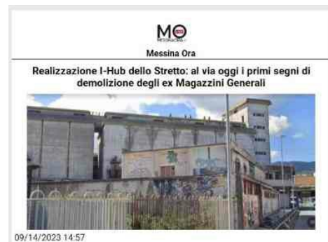
Al via oggi, giovedì 14 settembre, i lavori di demolizione del compendio immobiliare che sovrasta l'area portuale di Messina, costituito dalle tre costruzioni ex Magazzini Generali, Silos Granai e Mercato Ittico. Interventi che gettano le fondamenta per la nascita dell'I-Hub, finanziato dal Pon Metro. All'appuntamento, presenti il sindaco Federico Basile, il vicesindaco Salvatore Mondello; gli Assessori; il direttore generale Salvo Puccio; i Presidenti delle Partecipate comunali; e i rappresentanti della ditta aggiudicataria dell'appalto, il Consorzio Stabile Real Italy Scarl, di Vicenza. A questo momento storico per la città dello Stretto, non poteva mancare il deputato regionale Cateno De Luca, nonché sindaco della perla dello Jonio, che il 22 luglio del 2019, a seguito di una riunione della sua Giunta con gli organismi interessati dichiarò "I-Hub dello Stretto start". A seguire nel 2020, l'Agenzia nazionale di Coesione assegna all'Organismo Intermedio di Messina 74 milioni 767 mila euro per integrare i finanziamenti destinati a Innovation Hub, a seguito della presentazione da parte del Comune di Messina di un piano di investimenti straordinario sulle risorse del Recovery Fund, in convenzione con l'Università degli Studi di Messina per la co-progettazione. "L'Amministrazione del fare prosegue", dichiara il sindaco Basile: "oggi è una data significativa per la nostra Città. Le basi gettate per la creazione di un Parco scientifico che sorgerà su queste macerie rappresenta la continuità di quanto programmato dall'Amministrazione De Luca - prosegue Basile - che nella visione strategica di rilancio e sviluppo di Messina, che mi ha visto Direttore generale, e oggi Sindaco unitamente alla mia Giunta, al direttore Generale Salvo Puccio e alle Partecipate, stiamo raccogliendo i primi frutti di una programmazione
