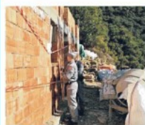
Il sequestro di un cantiere abusivo
