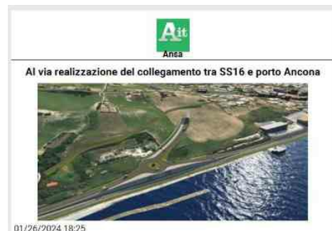
01/26/2024 18:25 Anas ha consegnato oggi alle imprese appaltatrici le attività di progettazione esecutiva, monitoraggio ambientale ed esecuzione dei lavori per la costruzione del nuovo collegamento stradale tra la SS16 "Adriatica" e il porto di Ancona, il cosiddetto Ultimo Miglio, opera attesa da oltre 30 anni "non solo dal capoluogo regionale, ma da tutte le Marche" ha detto il presidente della Regione Francesco Acquaroli. L'opera è considerata di rilevanza strategica nazionale e per questo affidata dal Governo a un commissario straordinario. L'atto di consegna è stato presentato in un incontro stampa alla presenza di Acquaroli, dell'assessore alle Infrastrutture Francesco Baldelli, dell'ad Anas Aldo Isi, del commissario straordinario dell'opera Paolo Testaguzza, del sindaco di Ancona Daniele Silveti. "La realizzazione di questo nuovo collegamento, prosecuzione del raddoppio della Statale16, offre una prospettiva nuova alla città di Ancona e a tutta la regione. Completa e unisce quelle che sono le nostre grandi infrastrutture rappresentate da porto, interporto e aeroporto - ha detto il governatore -. Un investimento strategico anche sul fronte della sostenibilità, perché agevola con maggiore fluidità il deflusso delle merci dallo scalo portuale. Un'opera che finalmente vediamo concretizzata, ridisegnando Ancona e le Marche come una piattaforma importante della vasta area rappresentata dal Corridoio europeo". Secondo Tisi, l'intervento "rientra in un piano di investimenti di oltre 4 miliardi di euro che Anas ha attivato nelle Marche, dove gestiamo una rete stradale di oltre 1.500 chilometri. Oltre al collegamento tra il Porto di Ancona e la SS16 stiamo realizzando il raddoppio della variante di Ancona, la variante alla Salaria in provincia di Ascoli Piceno e stiamo avanzando con la progettazione della E78 nel pesarese (mentre il 12 febbraio avverrà la consegna dei
