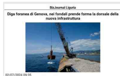
BizJournal Liguria Diga foranea di Genova, nei fondali prende forma la dorsale della nuova infrastruttura 02/07/2024 09:35 Realizzate oltre 1300 colonne sommerse con un milione di tonnellate di ghiaia. Con oltre 1 milione di tonnellate di ghiaia stesi sul fondale del mare lungo la dorsale di quella che sarà la nuova diga di Genova, infrastruttura strategica per il porto e la città, è stato traguardato il 40% dell'attività nei tempi previsti dal cronoprogramma. Questa imponente quantità, tre volte tanto il peso complessivo del Duomo di Milano, ha permesso di realizzare dall'inizio dei lavori, avviati il 4 maggio dello scorso anno, oltre 1320 robuste colonne di ghiaia sommerse che sorreggeranno la nuova diga. Per arrivare all'obiettivo di 1 milione, è stato incrementato nei mesi precedenti l'approvvigionamento del materiale proveniente dalle cave della Liguria, di Piombino e di Cartagena in Spagna, affiancando ai due mezzi nautici già attivi anche la bulk carrier Sider Olympia, capace di trasportare via mare 40.000 tonnellate di ghiaia. Per superare le condizioni meteomarine non sempre favorevoli, per la creazione delle colonne in profondità è stato previsto l'impiego di una grande chiatte, tecnicamente un "barge", attrezzata con 4 gru alte 40 metri e dotate di sonde vibranti a forma di ago lunghe 22 metri, che si andranno ad aggiungere al pontone attualmente in uso con due gru e due sonde. La prossima tappa importante per il progetto sarà l'avvio della prefabbricazione dei cassoni di media dimensioni della nuova diga foranea, programmato per il mese di aprile. Questi massicci blocchi cellulari di cemento armato, una volta realizzati, saranno posati ad una profondità massima di 50m, uno accanto all'altro, fino a completare l'intero disegno della nuova infrastruttura. In parallelo, avanzano le attività di bonifica bellica subacquea, completate per quasi il 70% e concentrate in questa fase sulla sesta e ultima area da bonificare, con l'obiettivo di concludere le operazioni entro l'estate. Paolo Piacenza, commissario straordinario Autorità di Sistema Portuale del Mar Ligure Occidentale: "Le attività per la costruzione della nuova diga foranea di
