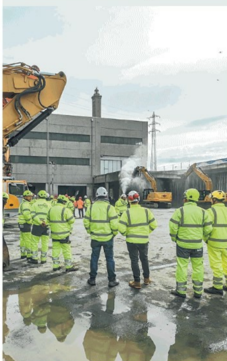
L'inizio della demolizione del capannone Csm (foto Balastro) GALLOTTI / PAGINA 2
