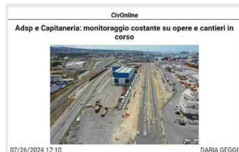
07/26/2024 17:10 DARIA GEGGI Daria Geggi CIVITAVECCHIA - Quella attuale, per il porto di Civitavecchia, è la stagione dei cantieri e della rivoluzione infrastrutturale. «Siamo uno dei pochissimi porti ad aver rispettato tutte le milestone del Pnrr - ha infatti confermato il presidente dell'Autorità di sistema portuale del mar Tirreno centro settentrionale Pino Musolino - le gare sono partite e da qui ai prossimi due anni lo scalo cambierà completamente volto. Sarà completata l'apertura a sud del porto che consentirà di separare la parte storica e turistica, da quella commerciale e di restituire alla città tutta l'area del Forte Michelangelo. Già da prossimo autunno sarà ultimato l'ultimo miglio ferroviario e tutte le banchine commerciali avranno binari per il trasporto merce a bordo». Un'opera questa fondamentale; una riorganizzazione completa del sistema ferro che garantirà uno slancio in più al porto di Civitavecchia. E poi il ponte di collegamento ed il prolungamento dell'antemurale, ma anche gli 80 milioni di investimento per il cold ironing che consentirà alle navi di spegnere i motori ed essere alimentate da terra. Opere e cantieri che si traducono necessariamente in un impatto anche sulla viabilità interna portuale e la sua operatività. «C'è piena collaborazione con l'Autorità di sistema portuale per minimizzare i disagi - ha assicurato il comandante del porto Michele Castaldo - il monitoraggio è costante per far sì che l'utenza tutta sia costantemente informata su eventuali disagi che potrebbero derivare dall'apertura dei vari cantieri e sullo stato di avanzamento dei lavori». Una verifica continua quindi per garantire al porto la sua operatività, con eventuali modifiche da mettere in atto per garantire la corretta esecuzione dei lavori ed evitare che sorgano problemi di ogni sorta. Ma l'Adsp guarda ancora avanti. Due i progetti all'orizzonte che Molo Vespucci vuole portare a termine. A partire dal completamento di quella parte di antemurale che garantirebbe di avere a disposizione un ulteriore terminal portuale, già previsto nei piani del 2005. «Se
