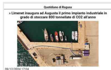
Quotidiano di Ragusa » Limenet inaugura ad Augusta il primo impianto industriale in grado di stoccare 800 tonnellate di CO2 all'anno 09/12/2024 17:04 Limenet inaugura ad Augusta il primo impianto industriale in grado di stoccare 800 tonnellate di CO2 all'anno. A un anno e mezzo dalla sua costituzione, Limenet, startup italiana che ha messo a punto una tecnologia innovativa che permette la rimozione della CO2 dall'atmosfera e lo stoccaggio in acqua di mare attraverso un processo chimico naturale con potenziali effetti benefici per l'ecosistema marino, presenta il primo impianto industriale realizzato ad Augusta (Siracusa). Un risultato che segna un passo significativo nello sviluppo dell'industrializzazione della tecnologia e nella crescita della società. Lo ha annunciato ieri Stefano Cappello, CEO e Founder di Limenet nel corso del convegno: "Limenet opening" al quale hanno partecipato diversi rappresentanti del mondo scientifico, industriale ed economico tra cui Stefano Caserini, Prof. Associato Università di Parma e Daniela Basso, Prof.ssa Ordinaria Università Milano-Bicocca, Jacopo Visetti, Co-Founder di Aither, Stefano Molino, Responsabile Fondo Acceleratori di CDP Venture Capital oltre che Francesco Di Sarcina, Presidente dell'Autorità Portuale di Augusta e Giovanni D'Angelo, Scheme Manager Sustainability & Energy di RINA. L'incontro, moderato da Beatrice Capano, Stakeholder and Impact Specialist di Limenet, è stata l'occasione non solo per fare il punto sui risultati della ricerca scientifica e sugli obiettivi futuri della società che contestualmente apre il capitale a nuovi investitori, ma anche per discutere in modo approfondito con degli esperti di settore sull'impatto del cambiamento climatico, della necessità di rimuovere l'anidride carbonica presente in eccesso in atmosfera e di limitare le emissioni per raggiungere la neutralità climatica entro il 2050. L'impianto presentato ieri, che ha sede ad Augusta, ad oggi è l'impianto più grande al mondo per capacità produttiva di stoccaggio di CO2 - 100kg/h - in mare sotto forma di bicarbonati di calcio (Ocean Vision database). Questo impianto di sequestro di CO2 ha una dimensione
