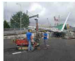
La Spezia, al via la demolizione del ponte Pagliari
