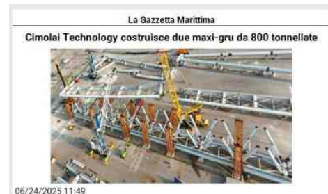
La Gazzetta Marittima Cimolai Technology costruisce due maxi-gru da 800 tonnellate 06/24/2025 11:49 Sono alte 110 metri, nel porto di Chioggia il campo base CHIOGGIA (Venezia). Due gru Goliath su rotaia da 800 tonnellate ciascuna: è il progetto di grande portata che nel porto di Chioggia vede al lavoro Cimolai Technology, leader internazionale nella progettazione e realizzazione di sistemi di movimentazione e sollevamento su misura per settori come la cantieristica navale, le infrastrutture e l'industria pesante. Dall'azienda - che ha alle spalle decenni di esperienza nella fornitura di soluzioni innovative e personalizzate per le più differenti specifiche tecniche - sono state presentate alle istituzioni le attività così da «garantire adeguata informazione circa le operazioni in corso e il cronoprogramma dei lavori», come spiegano fonti del gruppo. Le due gru, che sono destinate a operazioni di grandi sollevamenti in campo navale, rappresentano - viene sottolineato in una nota congiunta del gruppo imprenditoriale insieme all'Authority veneziana - «un'impresa senza precedenti in termini di ingegneria e logistica». Basti pensare che ogni gru «raggiunge un'altezza di 110 metri e uno scartamento di ben 118 metri»: sono progettate per lavorare «sia in modalità autonoma che in tandem con sollevamenti fino a 1600 tonnellate» e sono in grado di garantire «massima flessibilità operativa nei cantieri navali». Come sottolineato da Roberto Cimolai, amministratore delegato del Gruppo Cimolai Technology, una delle principali sfide del progetto riguarda la modalità di consegna: «Per la prima volta le due gru saranno trasportate tramite una chiatta e fornite completamente montate, testate e pronte all'uso, così da garantire la piena continuità operativa del bacino del cantiere del cliente». Il porto di Chioggia è il palcoscenico in cui si realizza un'impresa logistica e industriale che non ha eguali: le gru - viene messo in rilievo - verranno interamente assemblate presso il cantiere Cimolai Technology di Chioggia, situato nell'area portuale Porto Val da Rio. È da aggiungere che «da qui le strutture viaggeranno a destinazione finale su una "barge" speciale attraverso il Mare Adriatico, fino al sito del cliente a
