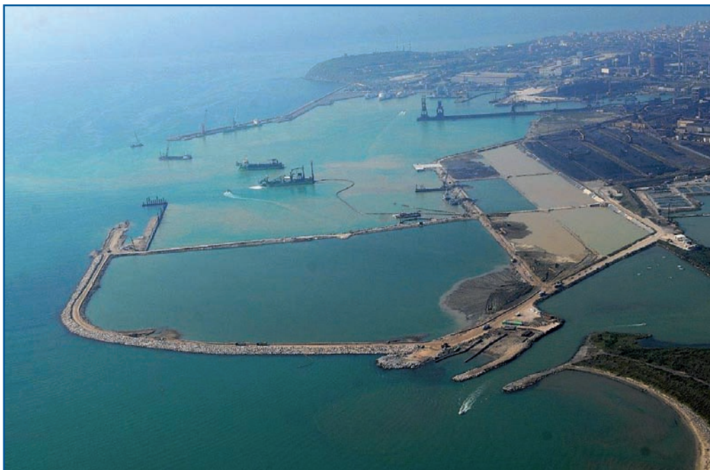
Stato dei lavori in corso al 9 agosto 2014
