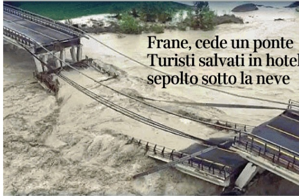
Il tratto di ponte sul fiume Trigno crollato per il maltempo ieri mattina sulla statale Adriatica 16, tra Molise e Abruzzo
