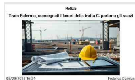
La cerimonia svoltasi il 29 maggio 2026 al parcheggio Basile ha ufficializzato la consegna dei lavori della tratta C del sistema tram di Palermo; il progetto avvia la fase I.1 e prevede circa tre anni di cantieri più un periodo di pre-esercizio per ottenere il nulla osta. Il 29 maggio 2026 è stato segnato dalla consegna formale dei lavori relativi alla tratta C del futuro sistema tranviario di Palermo. La cerimonia, svolta nel campo base allestito al parcheggio Basile, ha visto la partecipazione del sindaco Roberto Lagalla e dell'assessore alla Mobilità Sostenibile Maurizio Carta, oltre ai rappresentanti dell'ATI aggiudicataria. Questo atto amministrativo avvia il percorso operativo che, nelle intenzioni dell'Amministrazione, deve portare alla connessione tra poli strategici della città e alla rigenerazione urbana. Obiettivi e orizzonte temporale della fase I.1 La tratta C, che comprende il tracciato tra via Ernesto Basile e corso Tukory, rappresenta il segmento iniziale della Fase I.1 del piano tranviario cittadino, insieme allo svincolo Einstein. I tempi stimati prevedono una durata dei lavori di circa tre anni, seguita da un periodo di pre-esercizio di circa tre mesi senza passeggeri necessario per ottenere il nulla osta dall'Agenzia nazionale per la sicurezza delle ferrovie e delle infrastrutture stradali e autostradali. Questo cronoprogramma indica che la consegna delle aree cantierabili non coincide con l'avvio immediato di lavori di scavo su tutta la linea, ma stabilisce la tabella di marcia per le fasi tecniche successive. Che cosa comprende tecnicamente la consegna. Con la validazione del progetto esecutivo, effettuata dall'ente di validazione designato, è stata certificata l'idoneità della documentazione tecnico-economica e delle autorizzazioni correlate. L'ATI appaltatrice ha depositato il Progetto Esecutivo nella versione coordinata con i pareri e i nulla osta necessari, adeguandosi anche al prezzario regionale vigente al momento della gara. Questo passaggio formale è fondamentale per sbloccare le successive autorizzazioni operative e per pianificare le interferenze con altre opere presenti nelle aree
